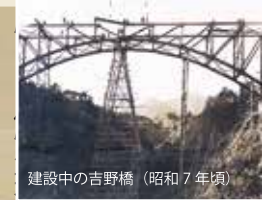
建設中の吉野橋(昭和7年頃)
